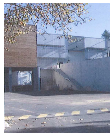
Conteneurs, carte de localisation des espaces de tri, plateforme de transfert - source: SIVED
