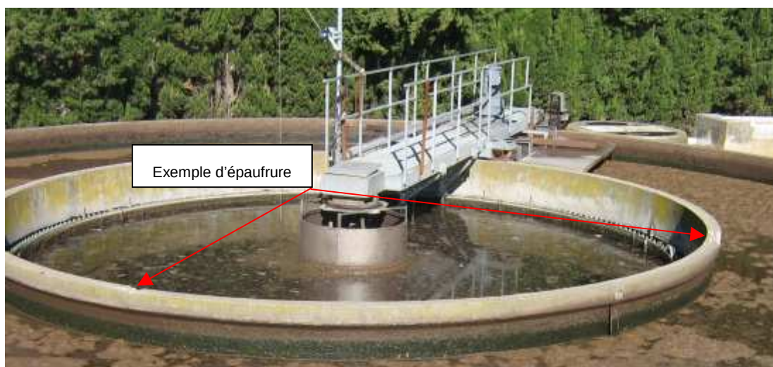
Bassin boues activées et clarificateur
