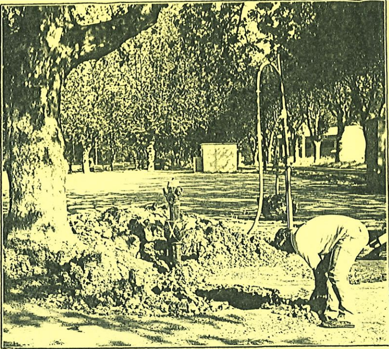
Mise en place d'un poteau-incendie
