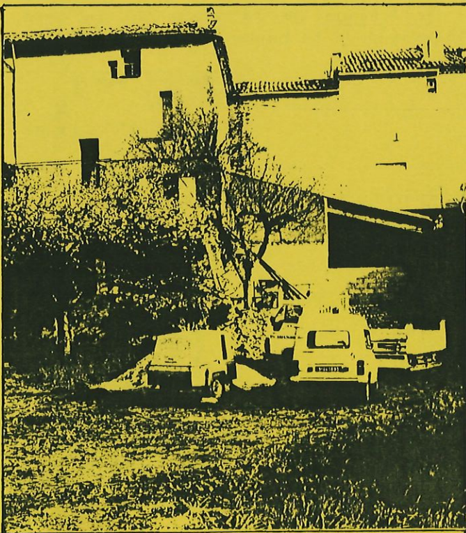
Le chantier à l'arrière de la future Mairie.
