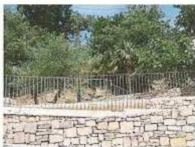
Fabrication et pose de garde-corps sur l'accès à la coopérative
