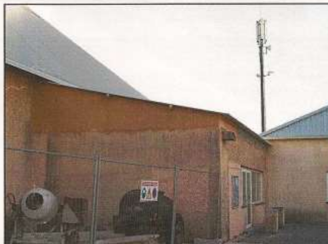
Travaux salle polyvalente
