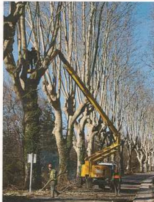
Elagage Allée des Platanes
