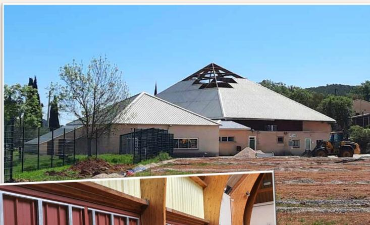
La **toiture du gymnase** a été entièrement rénovée, avec le remplacement des plaques défaillantes, la remise en état de tous les tirefonds et changement des plaques transparentes. L'étanchéité des 530m<sup>2</sup> de la toiture a été revue.
